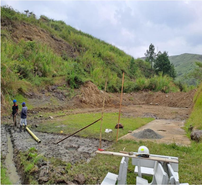
CANCHA # 4 – AMPLIACION DE CANCHA CON TECHOS Y PISO
